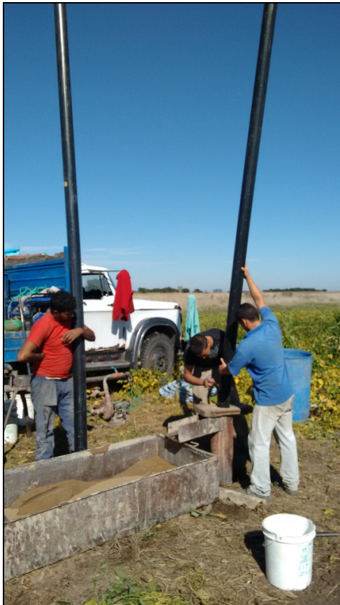
Bajada de cañería filtrante
