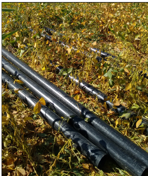
Detalle de la cañería ranurada filtrante
