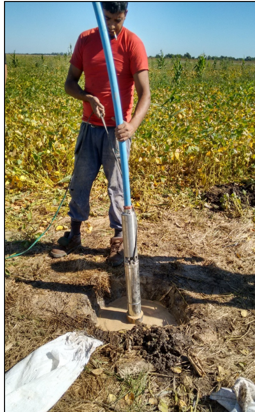
Bajada de bomba sumergible
