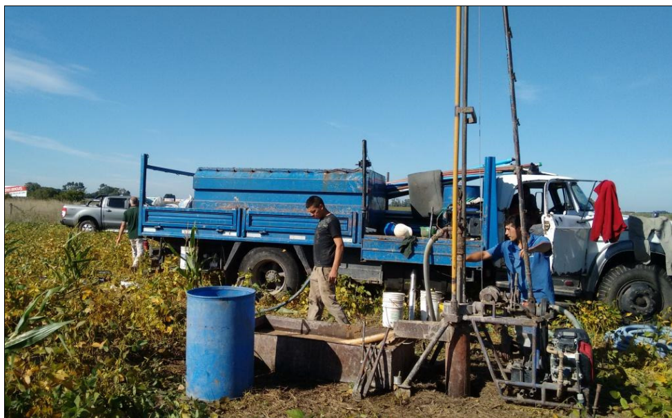
Vista general de la obra
