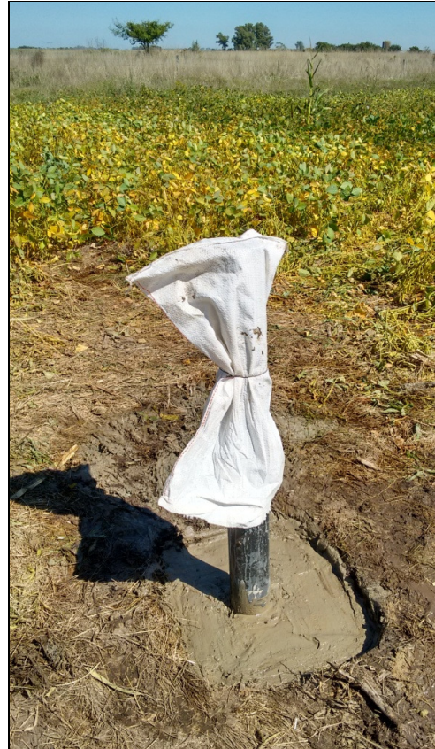
Pozo exploratorio finalizado
